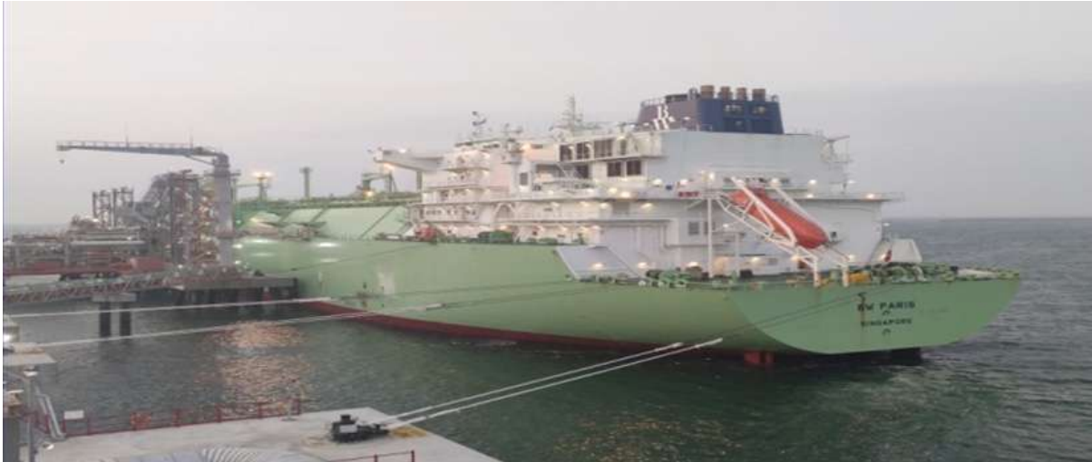
Indian Oil LNG Terminal
